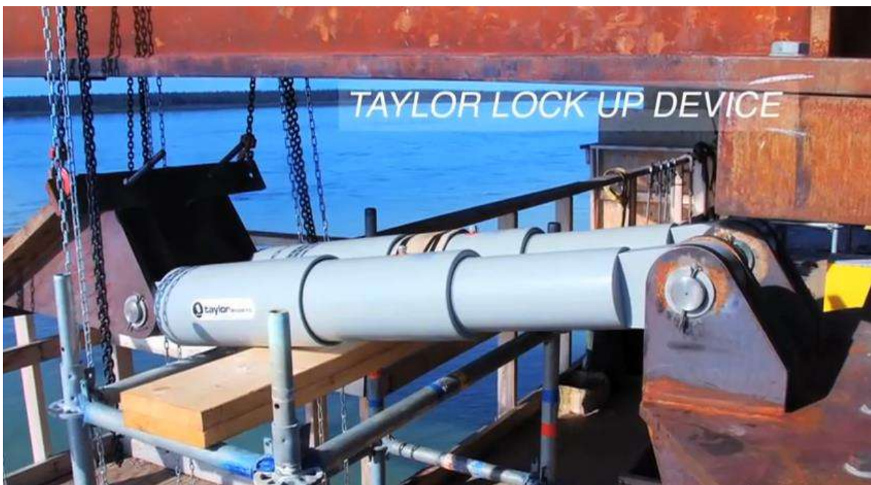
รูปที่ 6.10-8 อุปกรณ์ Lock up devices และ Viscous damper (ที่มา : https://www.youtube.com/watch?v=0TrYLFyvQe8 )
