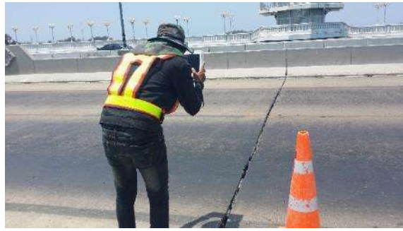
(ข) การตรวจสอบรอยต่อสะพาน
