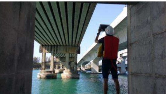
(จ) การตรวจสอบคาน I-Girder (ด้านล่าง)
