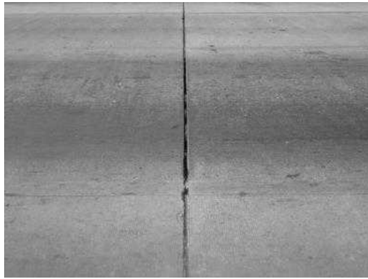
(ค) Joint Filler หลุดล่อน
