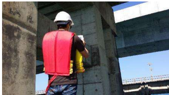
(ฉ) การตรวจสอบตอม่อสะพาน
