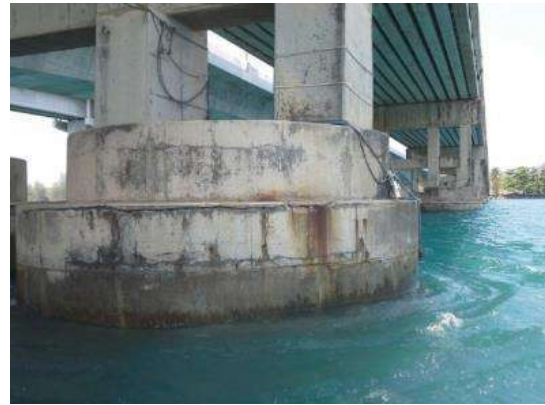
(ค) ครอบเสาเข็มมีหลุดล่อนเห็นเหล็กเสริมเล็กน้อย
