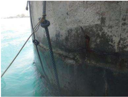
(ค) ครอบเสาเข็มมีหลุดล่อนเห็นเหล็กเสริมเล็กน้อย
