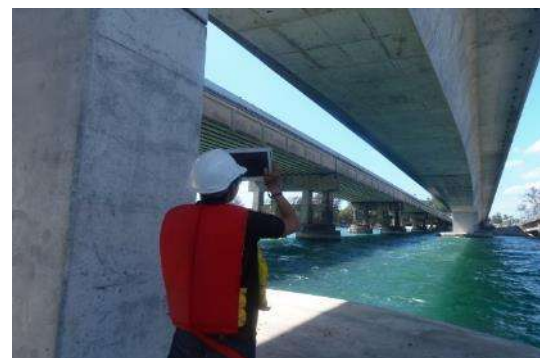
(ง) การตรวจสอบคาน Box Girder (ภายนอก)
