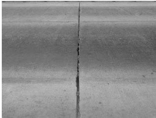
(ค) Joint Filler หลุดก่อน
