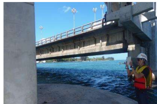
(ฉ) การตรวจสอบตอม่อสะพาน
