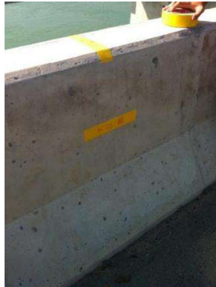
(จ) ตำแหน่งที่เหมาะสมสำหรับการติดตั้ง Accelerometer
