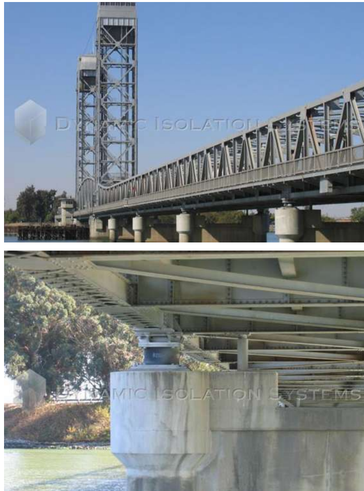
รูปที่ 6.10-14 ตัวอย่างสะพาน Rio Vista ที่ California ที่ติดตั้ง Dynamic Isolation System (ที่มา : http://www.dis-inc.com/applications.html#bridge_retrofits )
