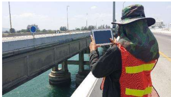
(ง) การตรวจสอบคาน I-Girder (ด้านข้าง)
