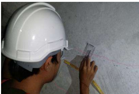
(จ) การตรวจสอบคาน Box Girder (ภายใน)
