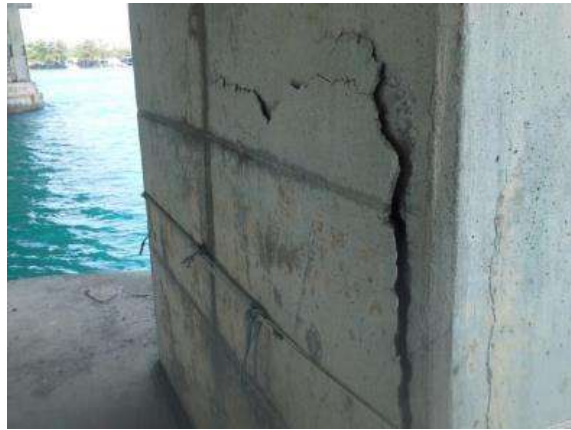
รูปที่ 1.3-2 ตัวอย่างการตรวจสอบสภาพโครงสร้างสะพาน
