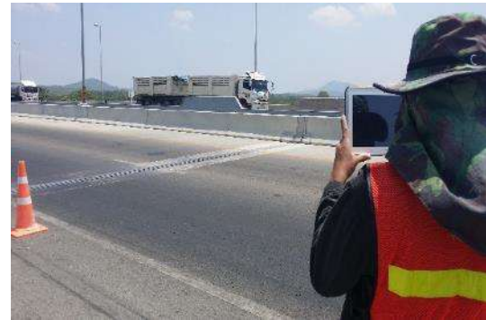
(ข) การตรวจสอบรอยต่อสะพาน
