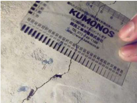
(ข) รอยแตกขนาดเล็กด้านในคาน Box Girder
