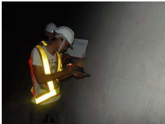
(ข) ผนังคาน Box Girder ด้านขวา
